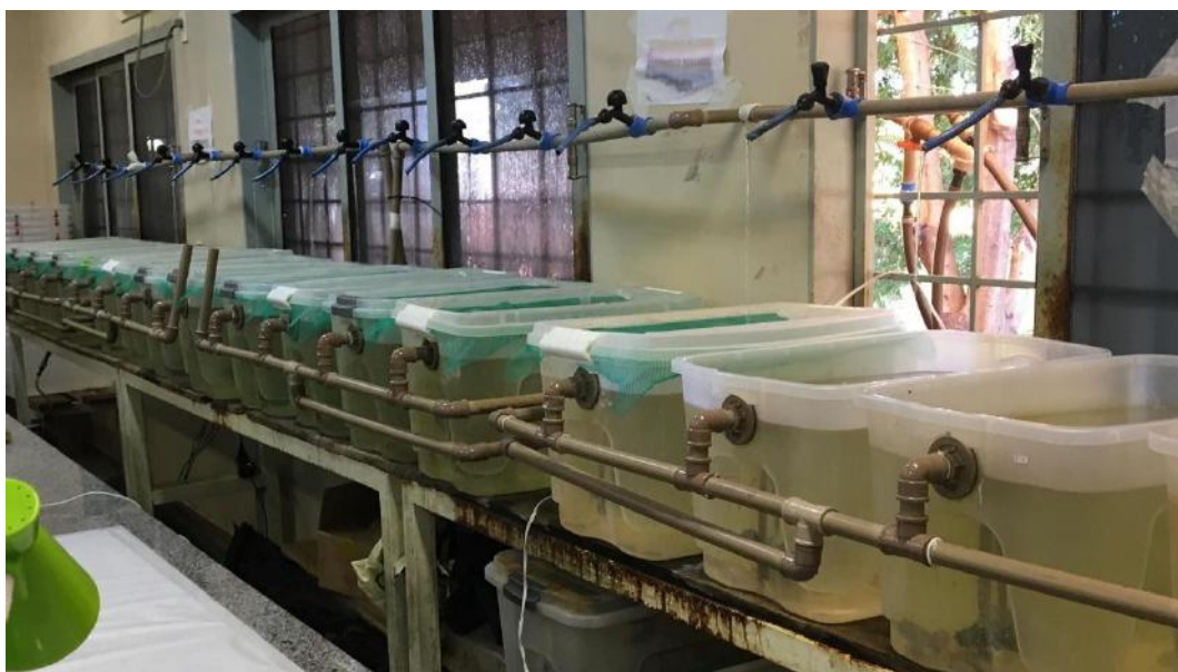
Figura 1 - Sistema de recirculação de água para o cultivo de alevinos de tilápia do Nilo.
